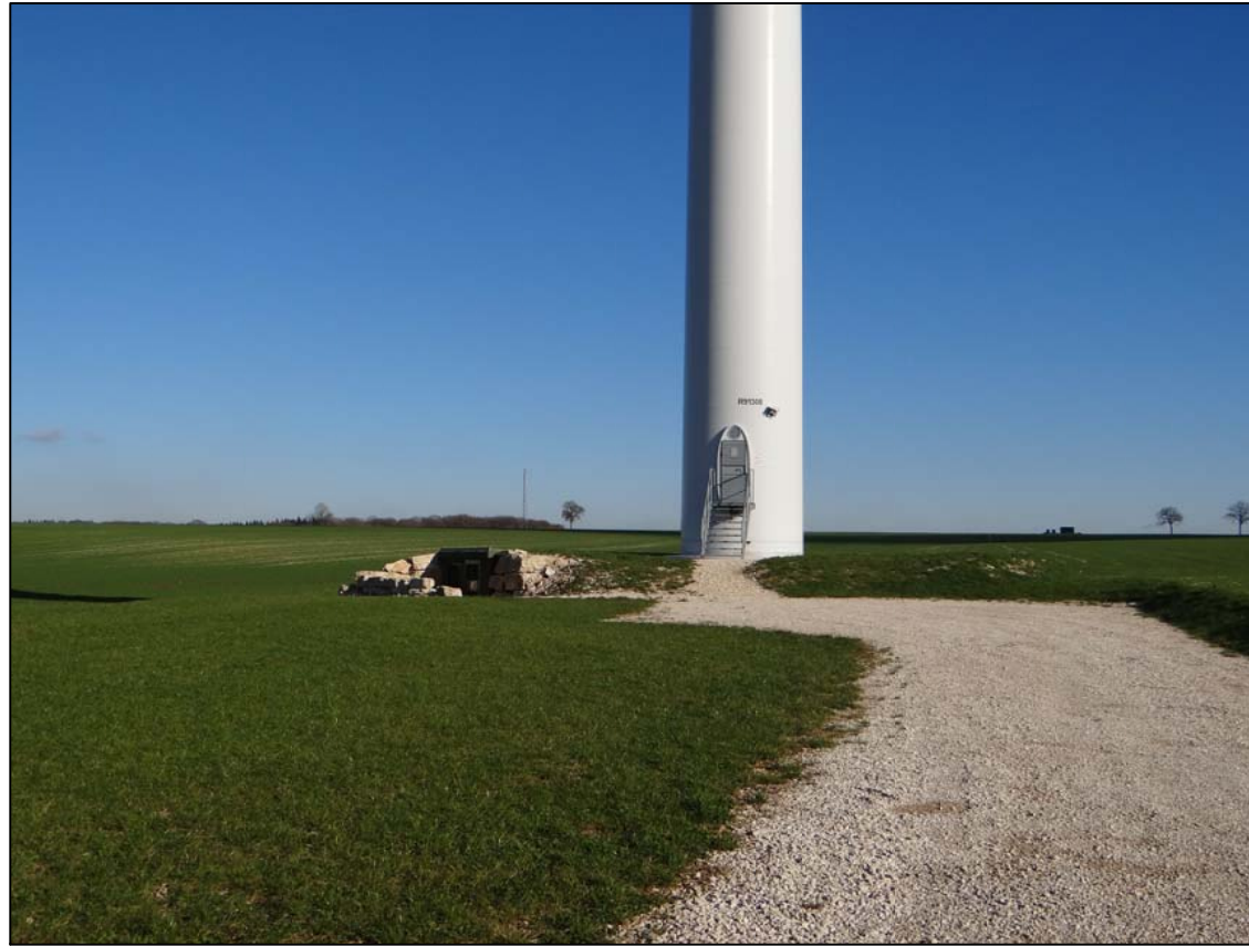
Configuration type du transformateur semi-enterré au pied de l'éolienne (exemple d'insertion d'un projet existant)
